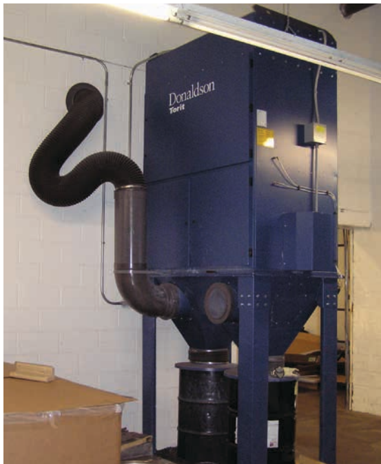
UMA 450 - Filtering Plastic from a CNC Machine
