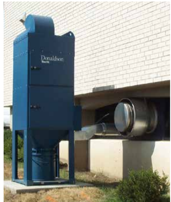
UMA 250 En una aplicación escolar de un taller de madera
