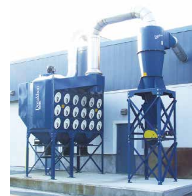
DFO & サイクロン - 溶射 (136 m 3 /min)
