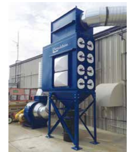
DFE - プラスチック加工 (453 m 3 /min)
