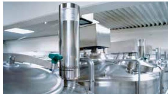
BelüftungsfILTER auf Lagertanks
