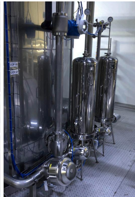
Über jeweils einen LifeTec PT N erfolgt die Sterilluftversorgung der beiden Fermenter (links). Durch isolierte Rohrleitungen wird der gefilterte Dampf für die Sterilisation zugeführt (Mitte). Die Sterilwasserbereitstellung für den Hauptfermenter läuft über zwei Filterstufen (rechts).
