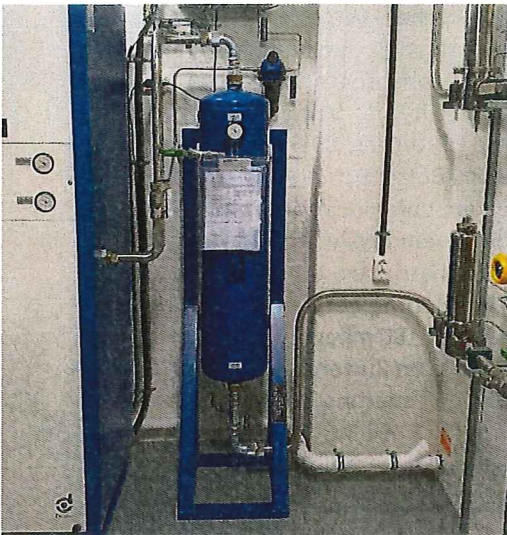
University Hospital Oslo: Atemluftgerät der Ultrapure ALG-S-Serie (li.) mit zusätzlichem Aktivkohleadsorber (Mitte) und den nachgeschalteten DF-Ultra-Filter-Partikelfiltern (re.).
