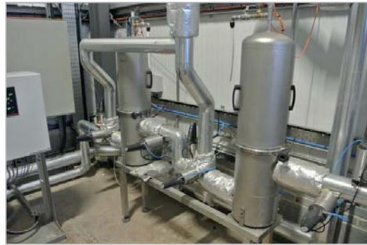
*Abb. 3: Die jeweils acht P-GSL N 30“-Filterelemente sind pro Filtrationsstufe in zwei Edelstahlgehäusen der Baureihe PF-IG untergebracht.*
