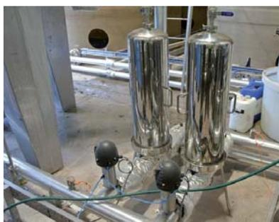
Abb. 4: Absolut sauber: Das Brunnenwasser wird in der letzten Stufe durch die LifeTec® PP-N Filter aufbereitet.
